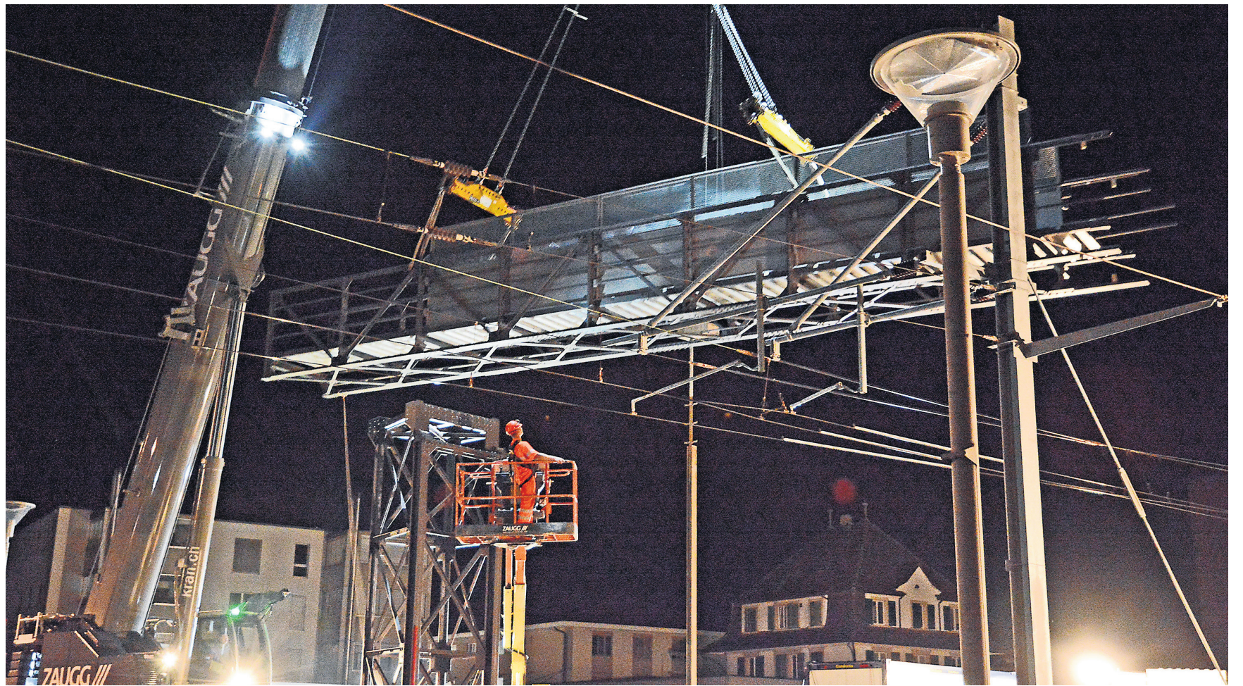
Die Passerelle schwebt über die Gleise an ihren alten Platz zurück.
