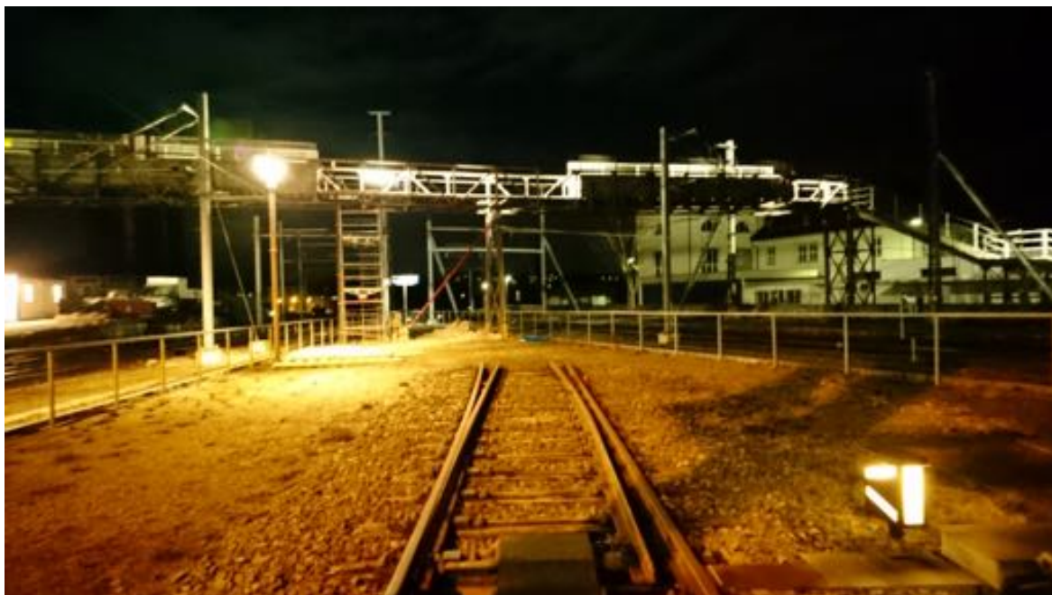
Abbau der Passerelle: https://murten.unsereregion.ch/murten-und-umgebung/582-100-jahre-alte-passerelle-in-kerzers-abtransportiert.html .
