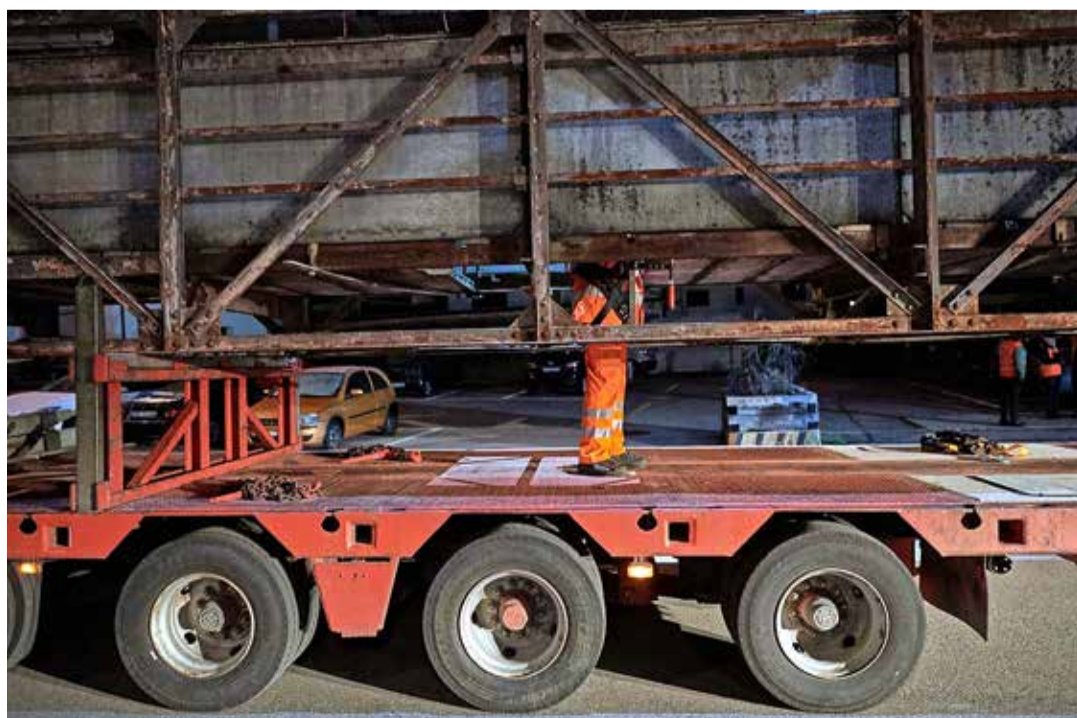
Fachleute werden die Nieten der Stahlkonstruktion prüfen und falls nötig durch Schrauben ersetzen.
