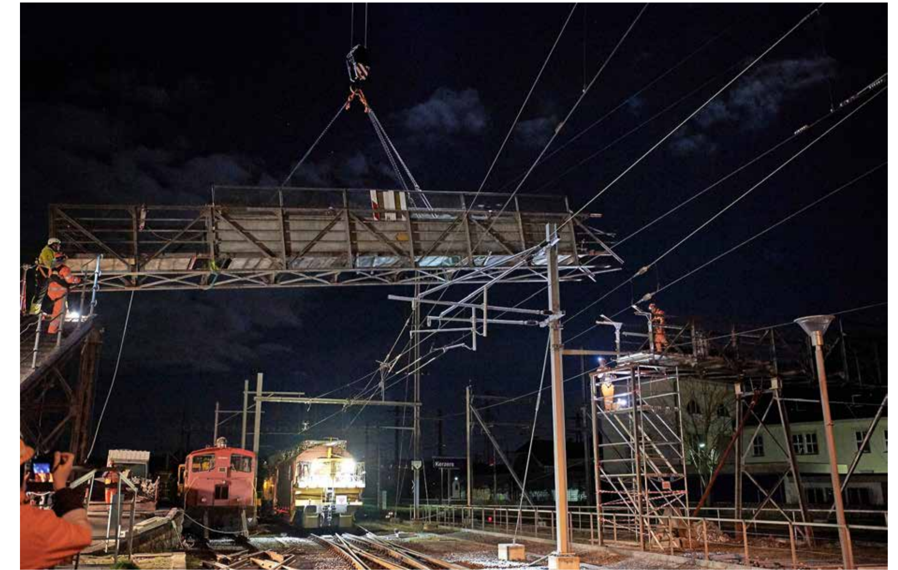
Ende Jahr übernimmt der Verein Passerelle Kerzers die Zugangsregelung, den Betrieb und den Unterhalt der Stahlfachwerkbrücke.
